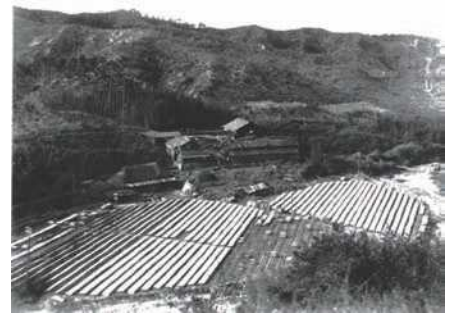
船坂川の河川敷にあった宮本寒天工場
