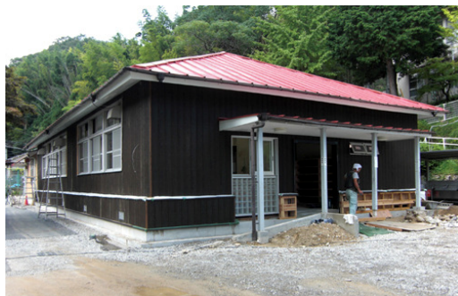
内装工が進むランチルーム
