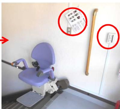
2階に到着。2階にも説明書と介添者用昇降ボタンがあります。ひじ掛け下のレバーを動かすとイスの向きを2階踊り場の方に向けることができます。ベルトを外して壁の手すりを持ってイスから降ります。
